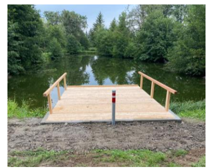
Am Weiher in Schambach wurde ein behindertengerechter Steg errichtet, um älteren und gehbehinderten Mitgliedern den Zugang zum Gewässer zu erleichtern (ILE Regionalbudget).
