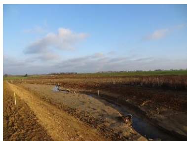
Der meandrierte Bachlauf des Gewässers III. Ordnung zwischen Haberkofen und Niederschneiding im November 2019 kurz nach der Baumaßnahme
