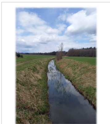
Nach fast drei Generation ist der ehemalige „Arbeitsdienstgraben“ im Straßkirchner Moos (heutige Bezeichnung Straßgraben) immer noch in guter Funktion
