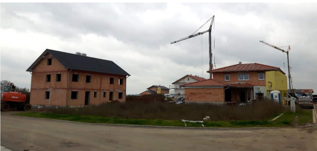
Einige Neubauten im neuen Baugebiet „Am Wasserwerk, BA 2“
