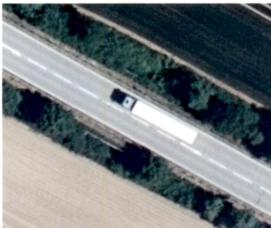
Abbildung 2: Durchlass unter B8
