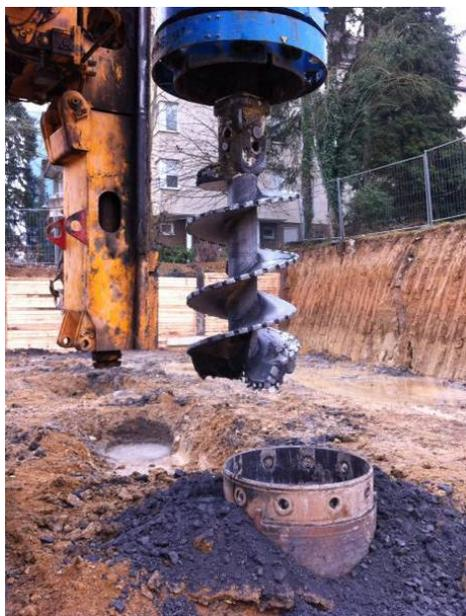
Abbildung 21: Gebohrte Unterbetonsockel
