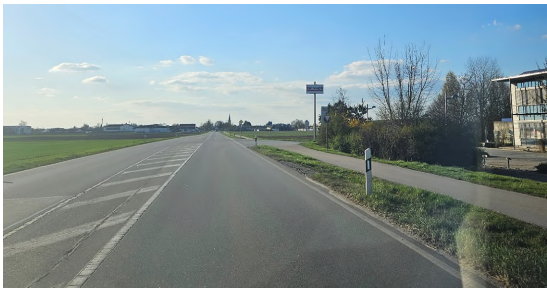
Radweg nördlich der B8 vor Straßkirchen
