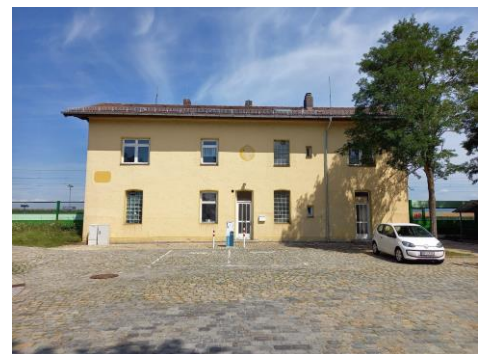
Das aktuelle Bild des sich nun im Gemeindeeigentum befindlichen Straßkirchner Bahnhofs mit der öffentlichen Elektrotankstelle, der ersten zwischen Straubing und Plattling. Der Bahnhof war und ist ein markanter Punkt im Ort aber auch in der geschichtlichen Entwicklung jeden Ortes.
